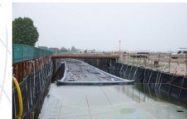
Folieconstructie onderdoorgang
