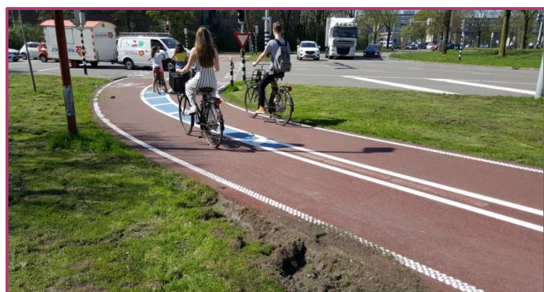
Afbeelding 3.3: Voorbeeld toepassing kantmarkering fietspad met ribbelmarkering (Verkeerinbeeld, 2018)
