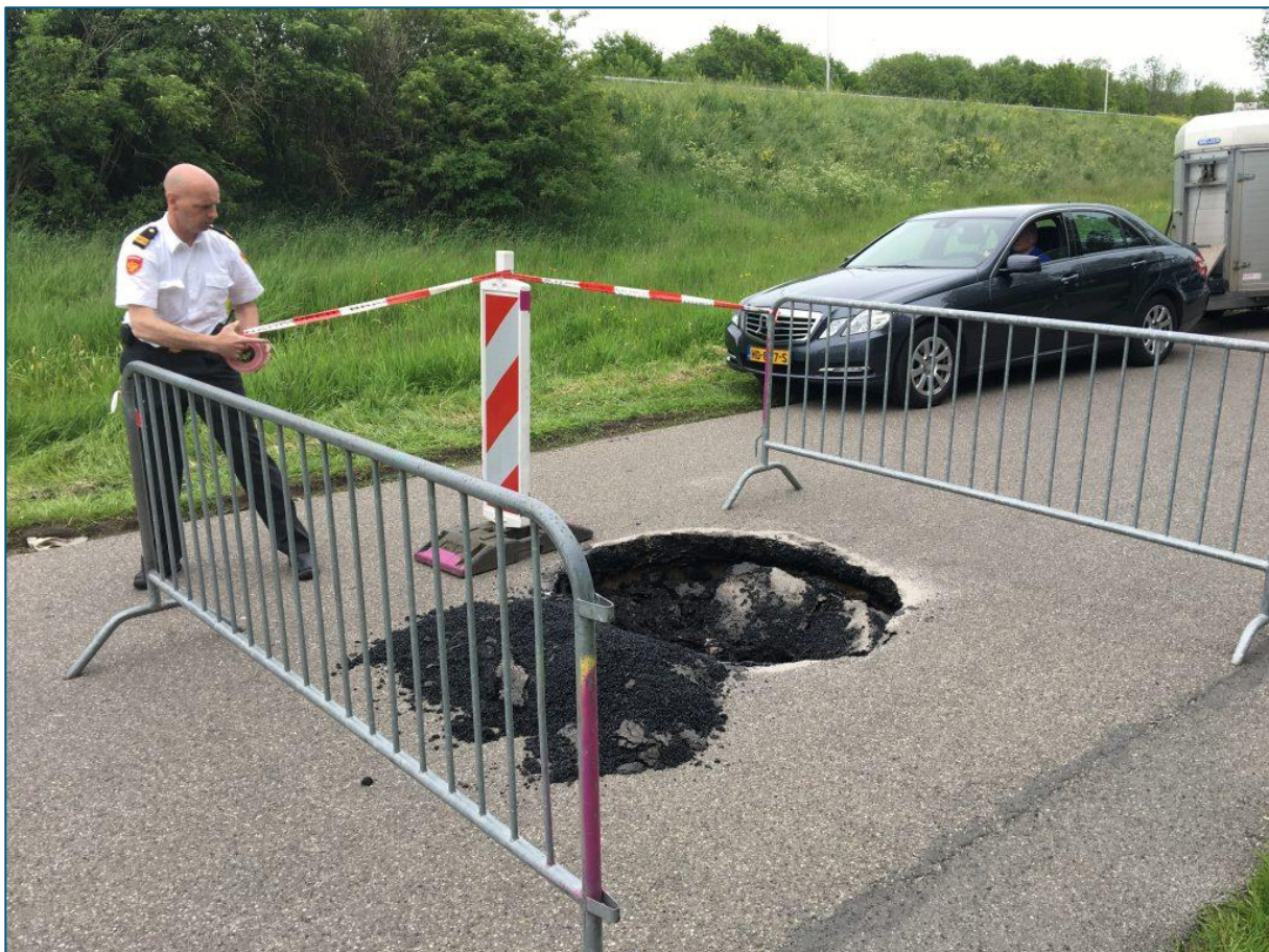
Figuur 28 Sinkhole in Woerden (Woerden.tv, 2017)
