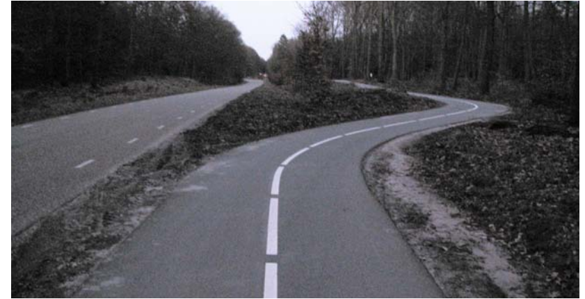
Waarschuwingsmarkering volgens CROW 230 Ontwerpwijzer Fietsverkeer voorzieningenblad V4. Kantmarkering ontbreekt hier nog.
