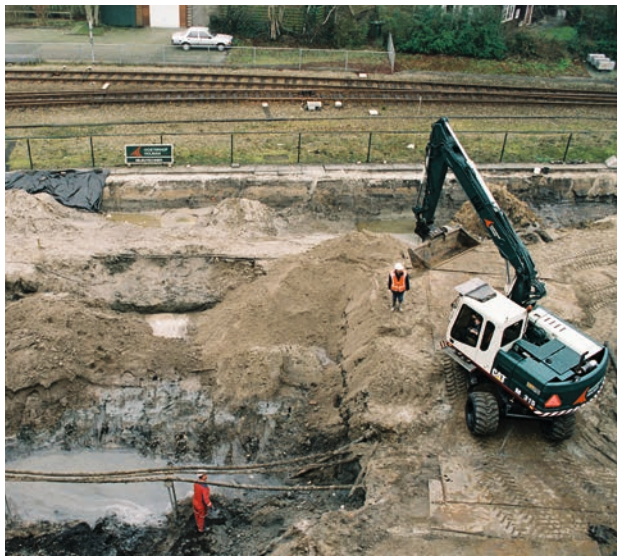
Uitvoeren bodemsanering (foto Lex Broere)
