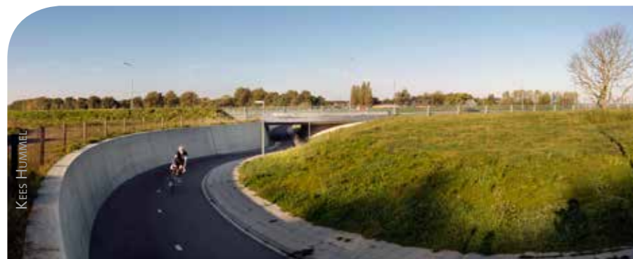
Fietstunnel onder de N9 bij Schoorldam
