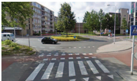
Afbeelding 7.4 Berglaan – Splitting - Zuiderdwarsvaart
