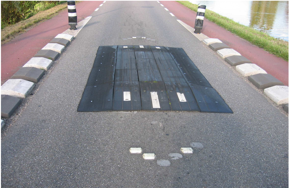
Rechthoekige drempel met richels en obstakels aan weerszijden. 60 km/u toegestaan.
