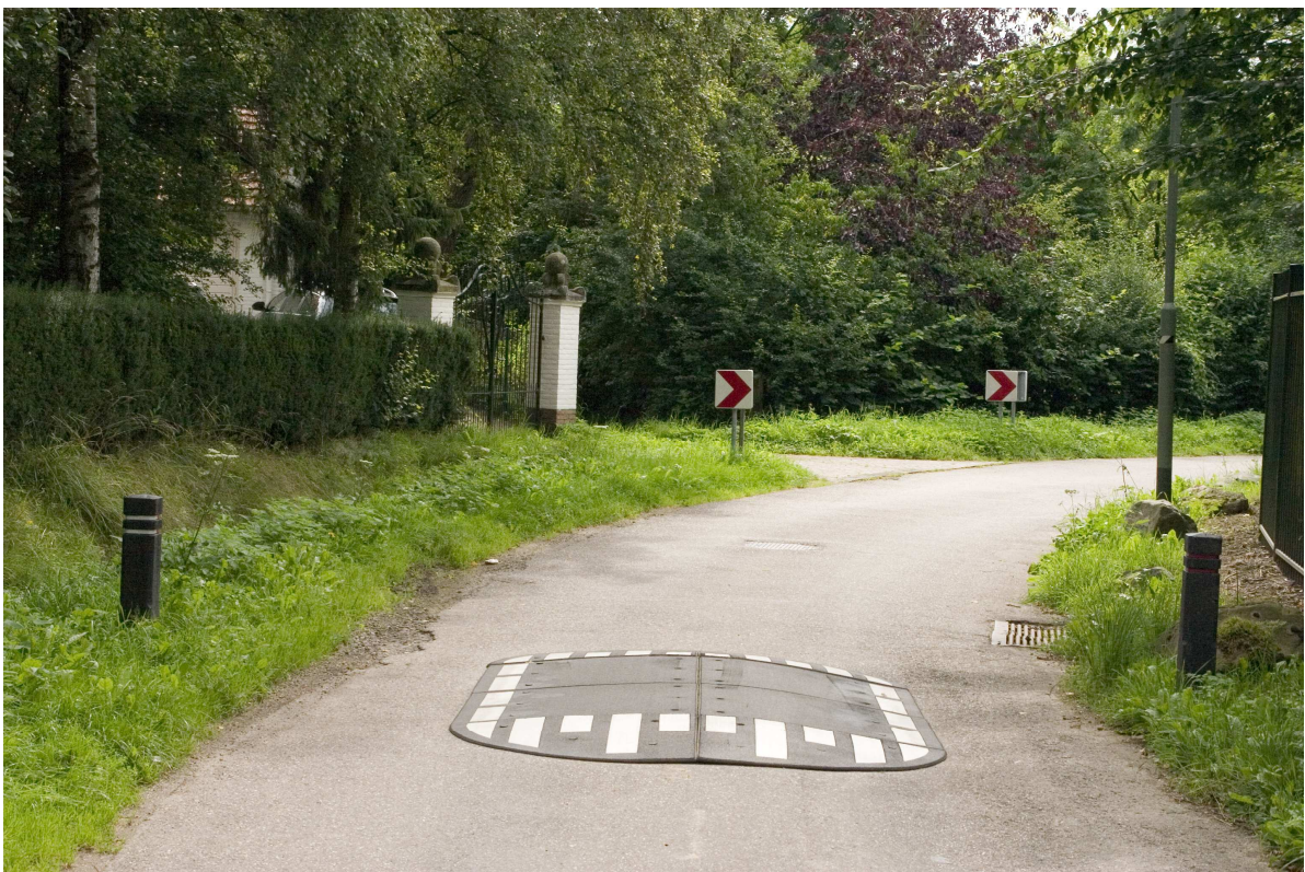
Gemonteerde ovale drempel, zowel voor als na een bocht aangebracht. 60 km/u toegestaan.
